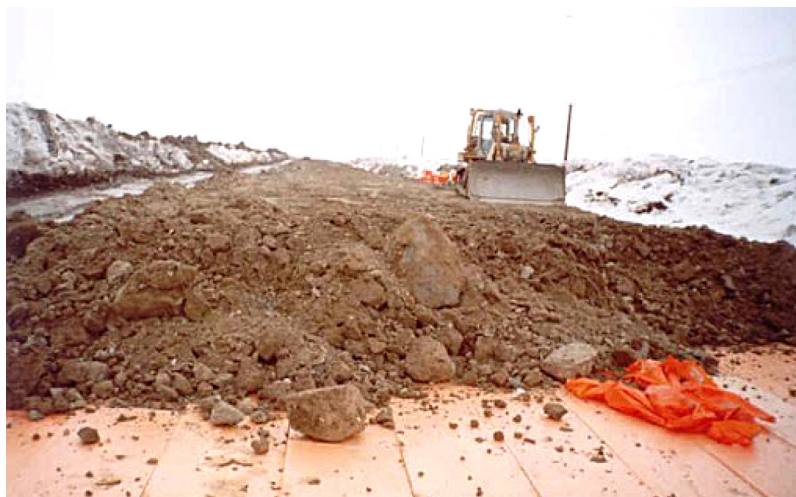
Рис. 2. Устройство земляного полотна с теплоизоляционными плитами «ПЭНОПЛЕКС»
